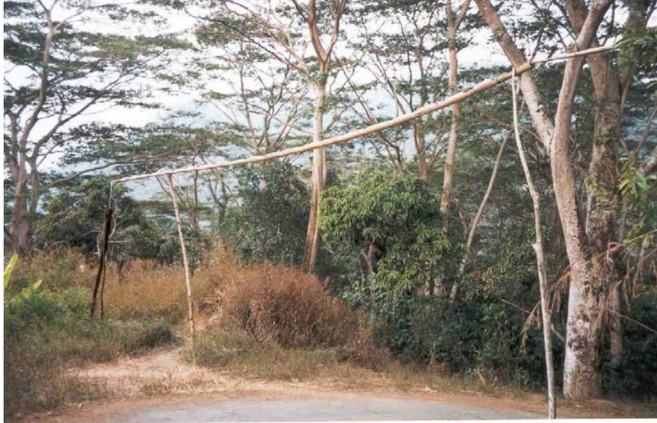
**Figura 11– Transporte de água através de um canal em bambu.**
