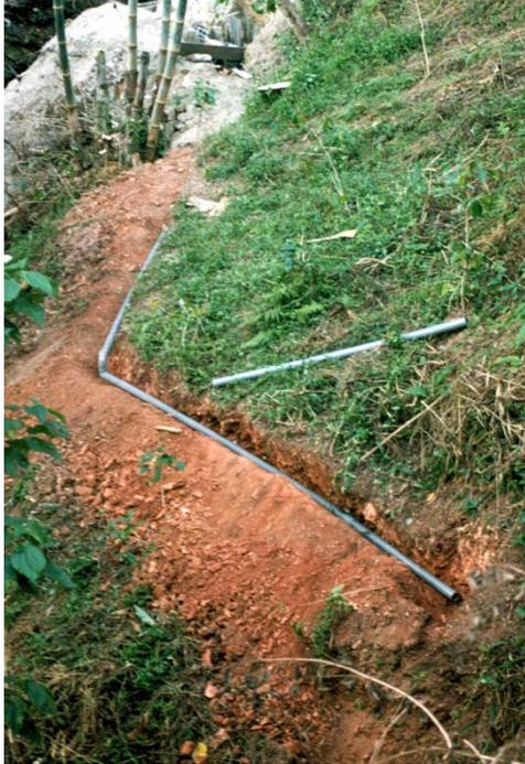
Figura 31-colocação das condutas
